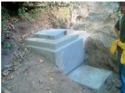
Obra de captació en una font d'aigua
